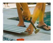
Fixieren Sie den ersten Teil der Laufschienen links und rechts vom Becken. Bohren Sie Löcher, fügen die Dübel ein und schrauben Sie die Schienen fest. Anschließend montieren Sie die Endkappen.
