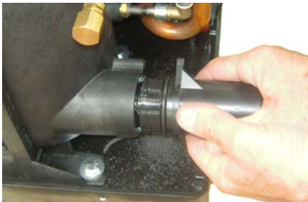
12) Den Anschluss anstelle des alten Anschlusses anbringen.
