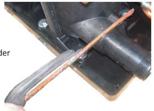
6) Den Anschluss an der Basis des Kondensators schneiden (darauf achten, den Kondensator nicht zu beschädigen).
