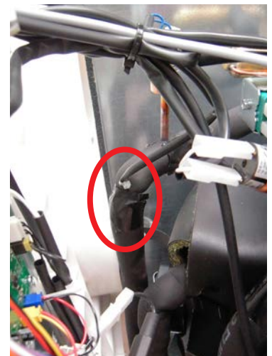
ST5 Fühler an der Druckseite des Kompressors
